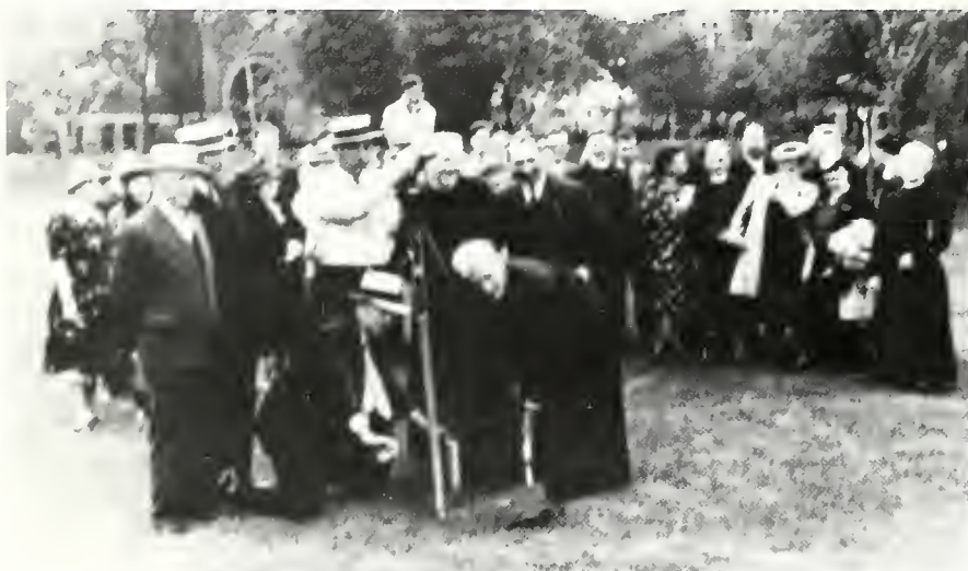
Ground-breaking for Madonna Della Strada
